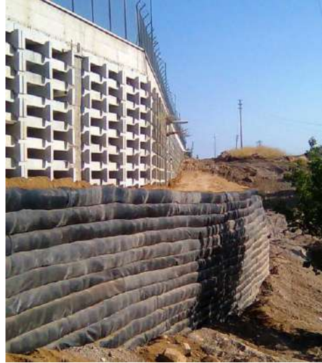
Şekil 8. ‘Tekstil Blok’lu Bohçalama Duvar İmalat Görüntüsü
