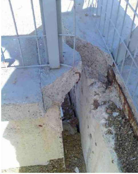
Şekil 3.a Parapet Bölgesi Görüntüsü
